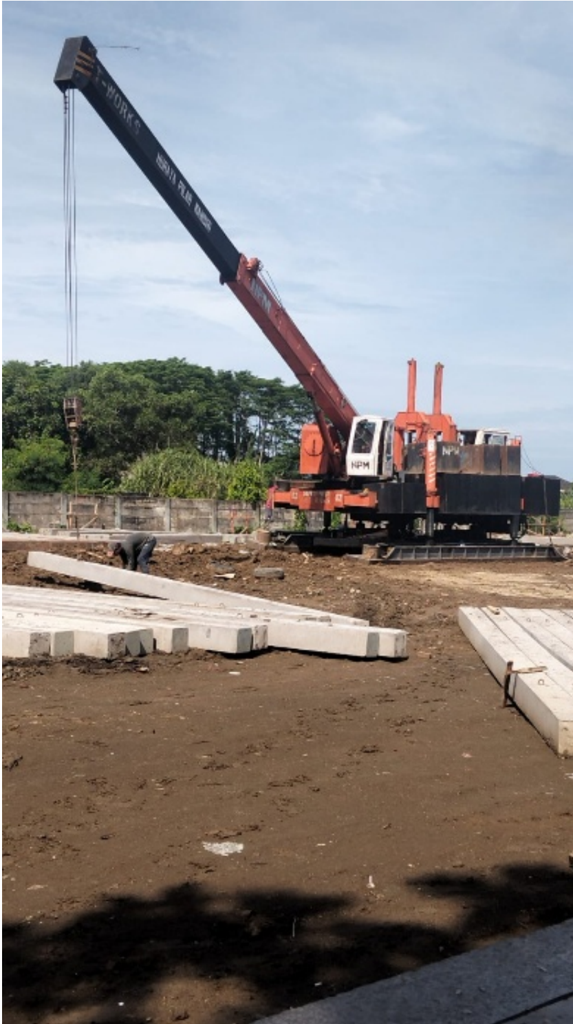
Figure 5. 5 Proses Pemancangan
