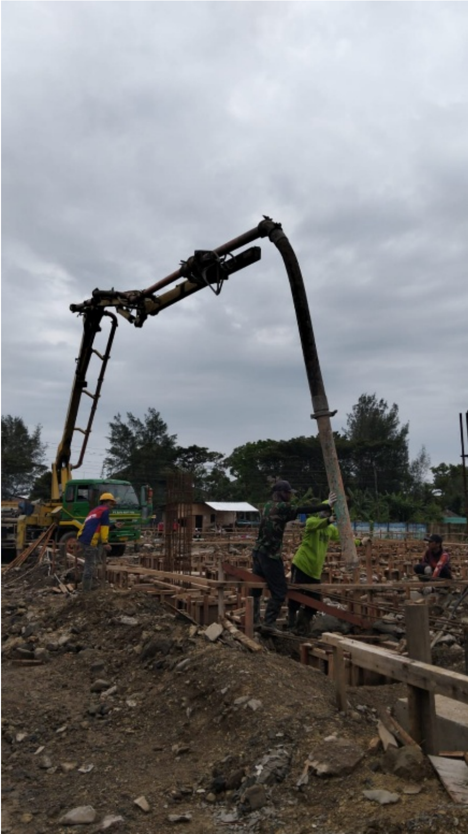
Figure 13. 13 Pengecoran PC1 dan PC2 dengan Alat Concrate Pump
