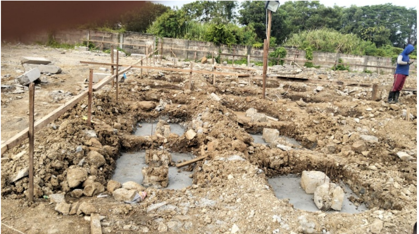
Figure 9. 9 Pekerjaan Lantai Kerja PC1
