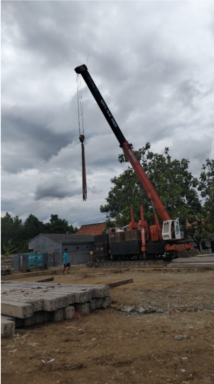
Figure 6. 6 Proses Pemancangan
