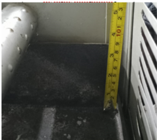
Figure 8. Tinggi pemasangan arang yang disarankan (5-6 cm)
