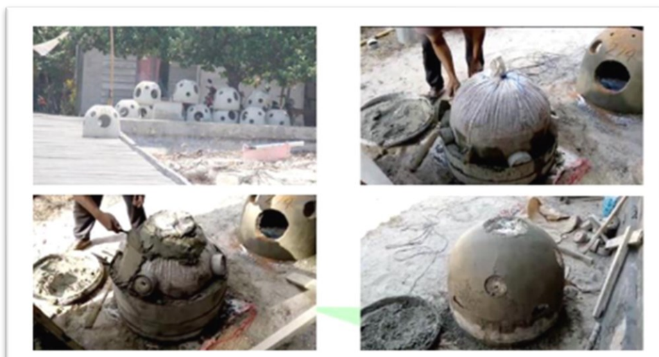
Gambar 3. Media Transplantasi Terumbu Karang bentuk Kubah
